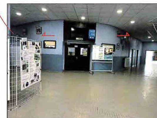
Vue 2 : intersection couloir
